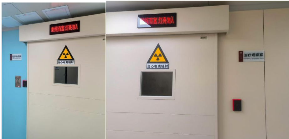
治疗观察室、粒子治疗室门禁系统及警示标识
